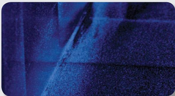
**foto 17** particolare dello sporco residuo evidenziato dalla lampada di Wood in prossimità dello spigolo del canale in lamiera zincata
